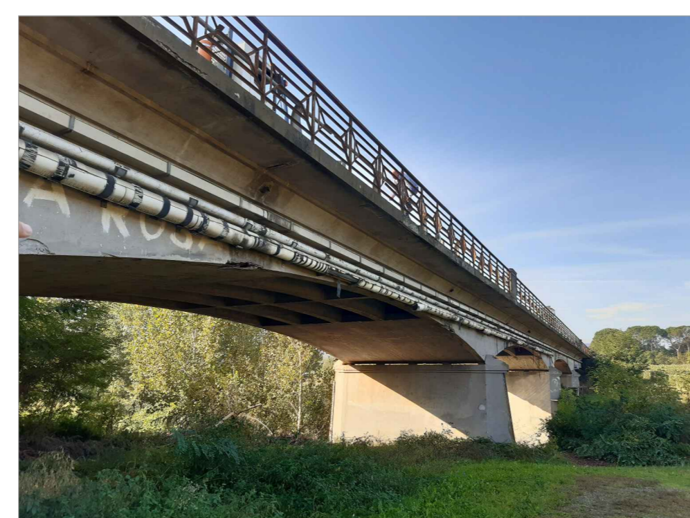
Prospetto di valle - tubazioni ACQUEDOTTO TERMALE staffate sul lato esterno delle travi di riva dell'impalcato
