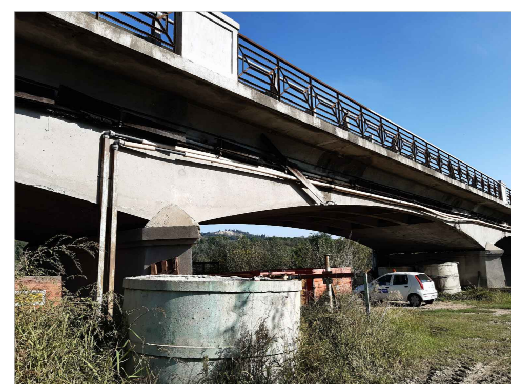
Prospetto di valle - tubazioni ACQUEDOTTO TERMALE staffate sul lato esterno delle travi di riva dell'impalcato
