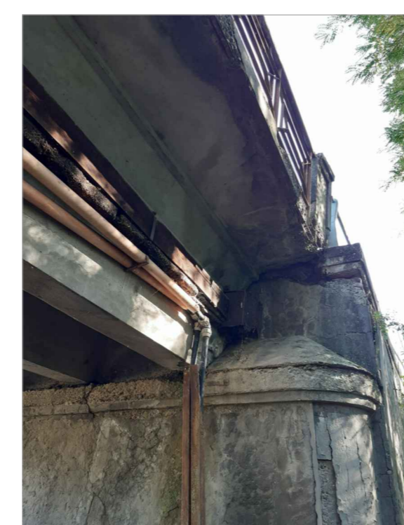
Passaggio delle tubazioni all'interno delle spalle
